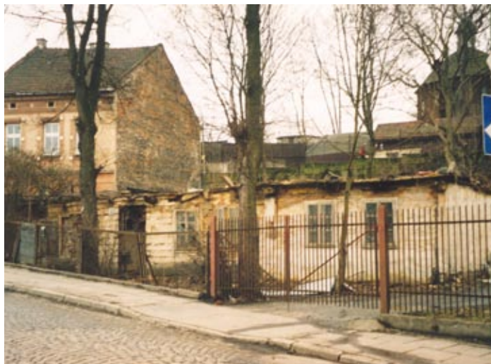
Wiosna 2006. Drewniany domek jeszcze stoi, choć już bez dachu, który zarwał się pod zalegającym śniegiem.
